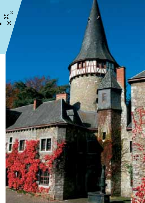
• Hergenrath Château Eyneburg
