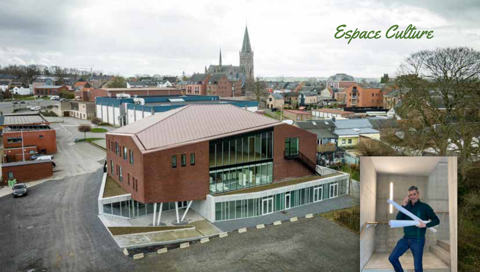
Jean-Pierre Donéa, l'architecte aubelois qui a conçu l'Espace Culture aubelois.
