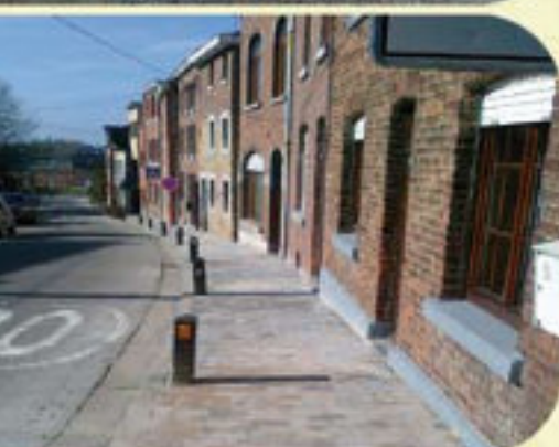
◀ Réfection du trottoir rue de Gorhez
