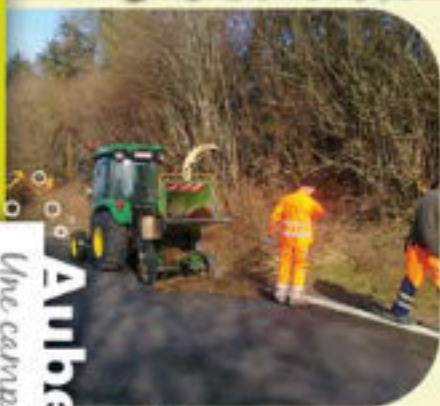
◀ Nettoyage des talus à La Clouse
